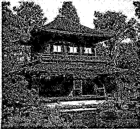
❷ 慈照寺銀閣 足利義政の東山山荘内に造営された2層の観音殿。下層は禅院造、上層は禅宗様。銀箔を覆く計画があったか否かは不詳。着工から約7年で完成。庭園は若狭弥作の池泉回遊式で、一部石組みを採用。
